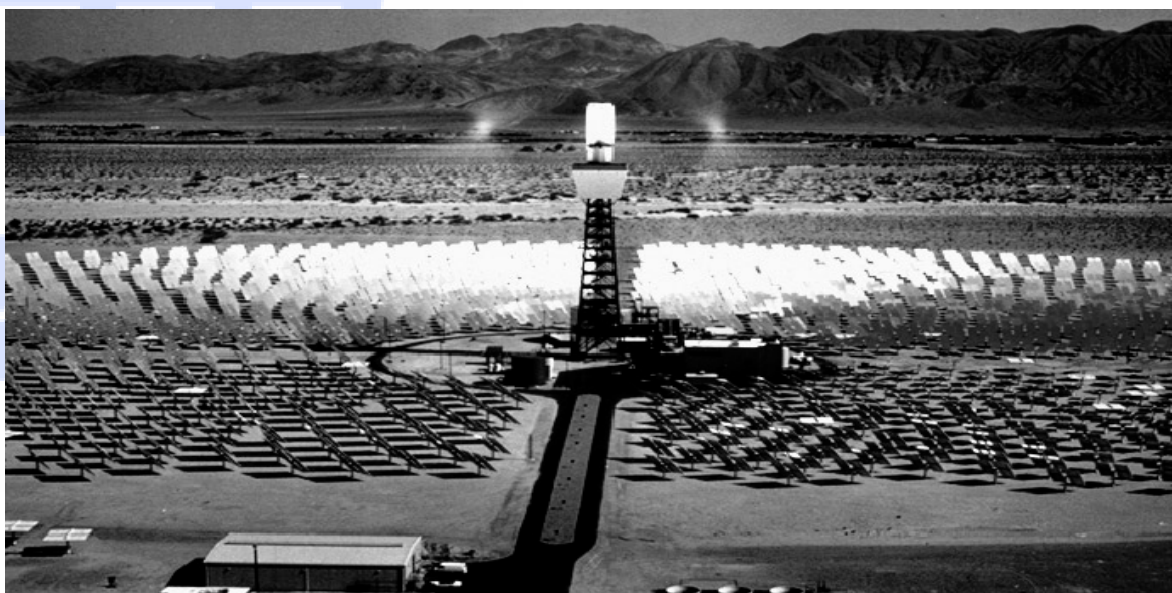
Fig. 14b: Solar I, la planta solar de torre central de 10 MW eléctricos, situada en el sur de California.
