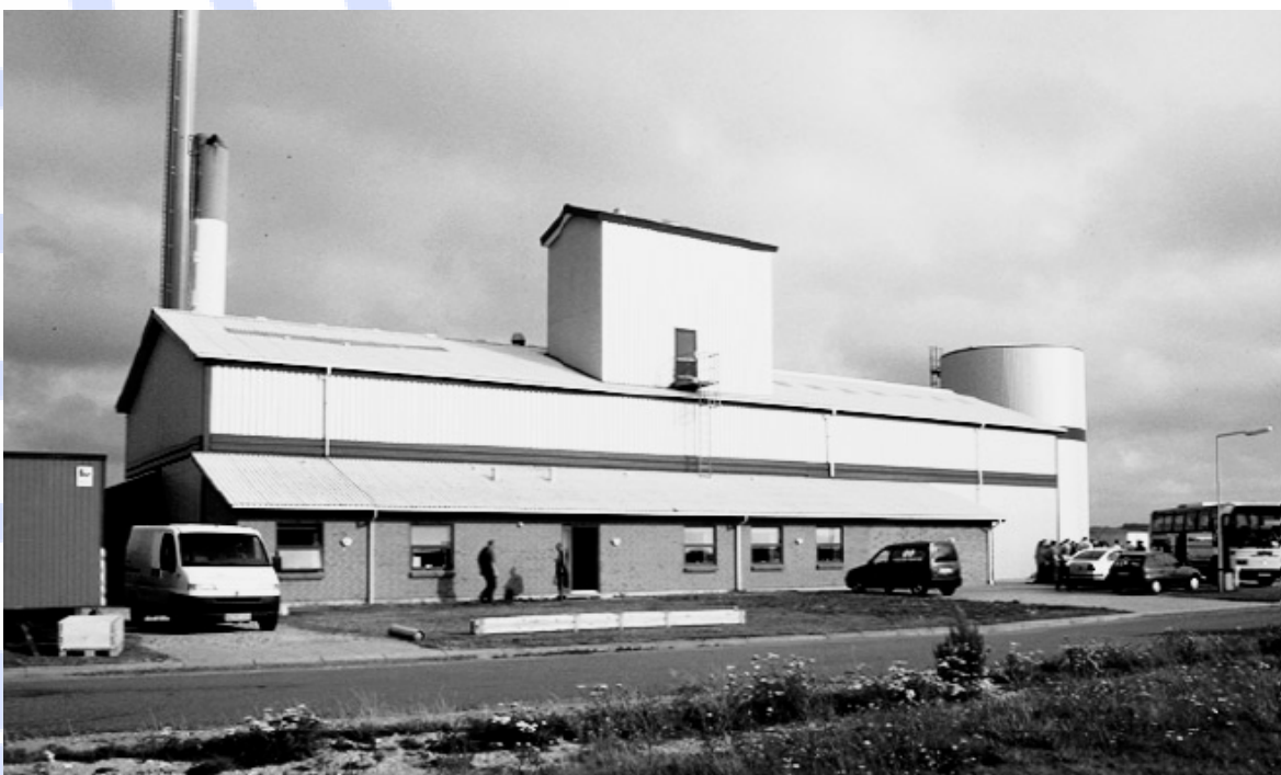
Fig. 5b: Planta comunitaria de cogeneración, alimentada con viruta de madera, produce calor y energía eléctrica para 300 familias en Dinamarca.
