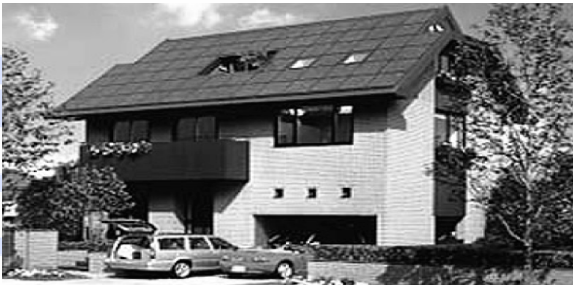
Fig. 16a: Una aplicación solar residencial en una azotea en Japón. Fuente: Foto de la Asociación Fotovoltaica Japonesa
