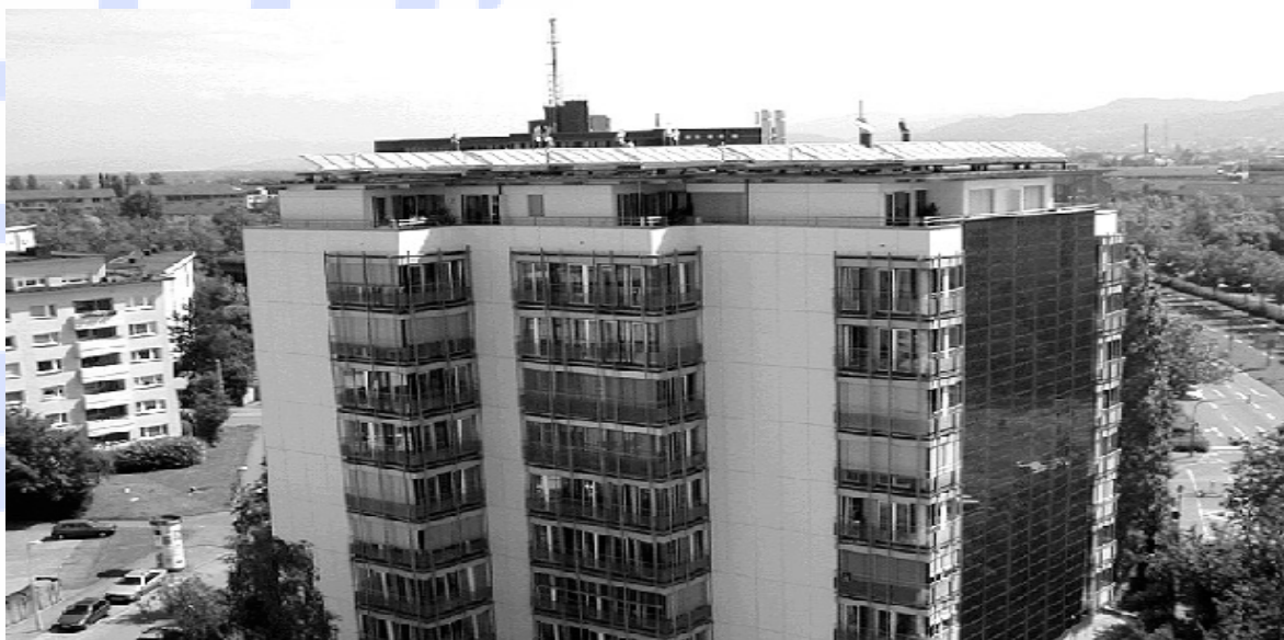
Fig.16b: Un edificio multifamiliar en Freiburg, Alemania, que utiliza la azotea para el calentamiento solar de agua y la pared del sur para la producción de energía eléctrica con módulos fotovoltaicos.
