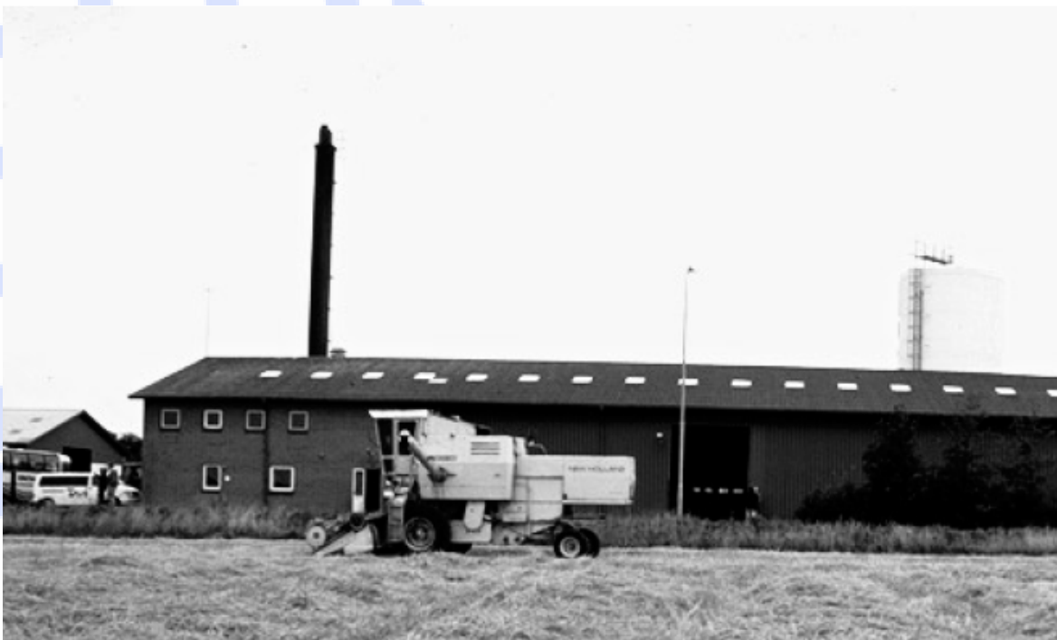
Fig. 6b: Planta comunitaria de cogeneración, alimentada con paja de desecho que crece en una vecindad cercana, para 300 familias en Dinamarca.
