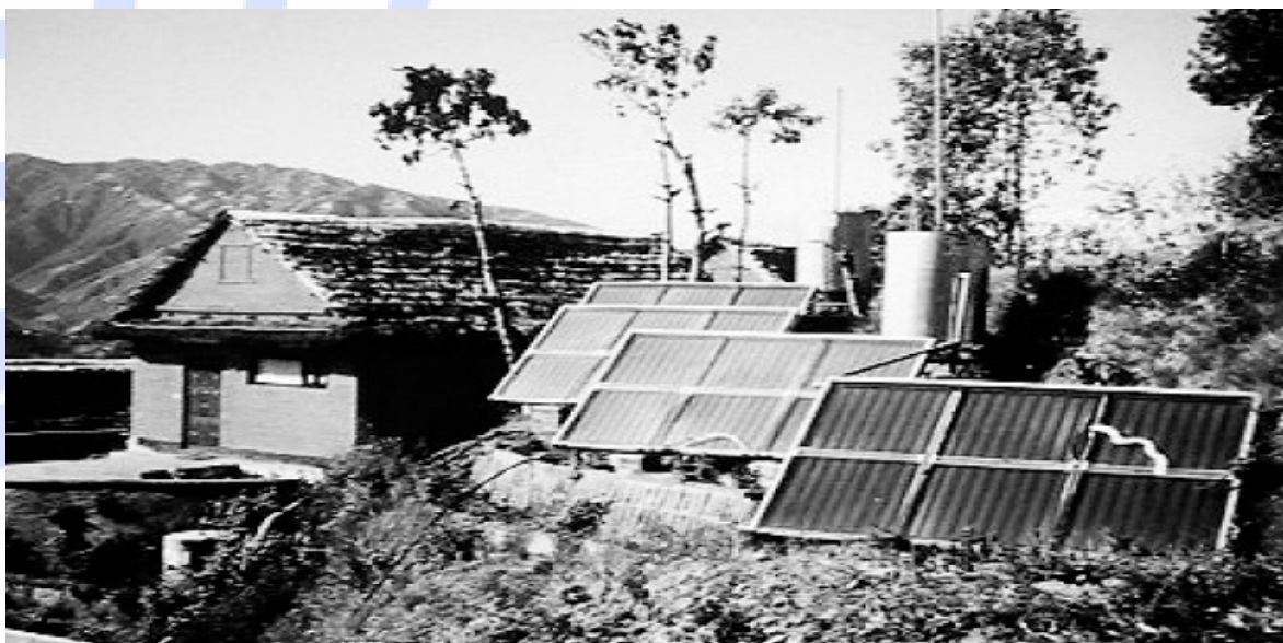
Fig. 13b: Calentamiento solar de espacios y de agua en Katmandú, Nepal. Fotografía tomada por el Dr. Donald Aitken
