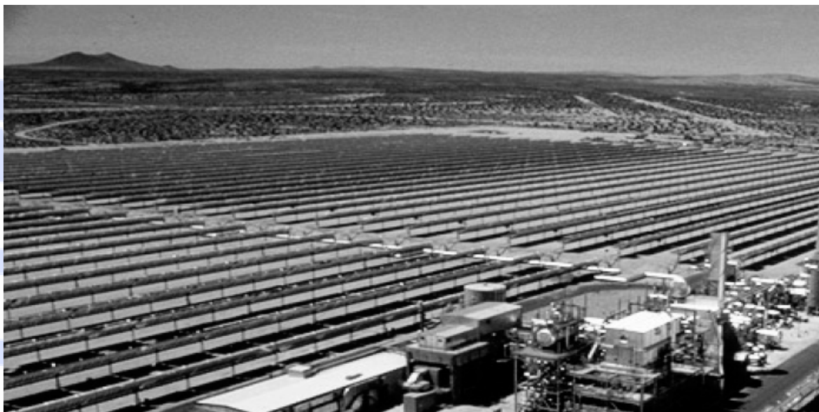
Fig. 14a: Una porción de la planta termosolar generadora de electricidad más grande del mundo (a la izquierda), parte del sistema de 354 MW eléctricos en el Sur de California. Se muestra también el generador termoelectrico enclavado para lograr un 25% de operación "híbrida" y para nivelar la salida del sistema solar, que presenta además una sinergia útil entre la energía renovable y la energía convencional.
