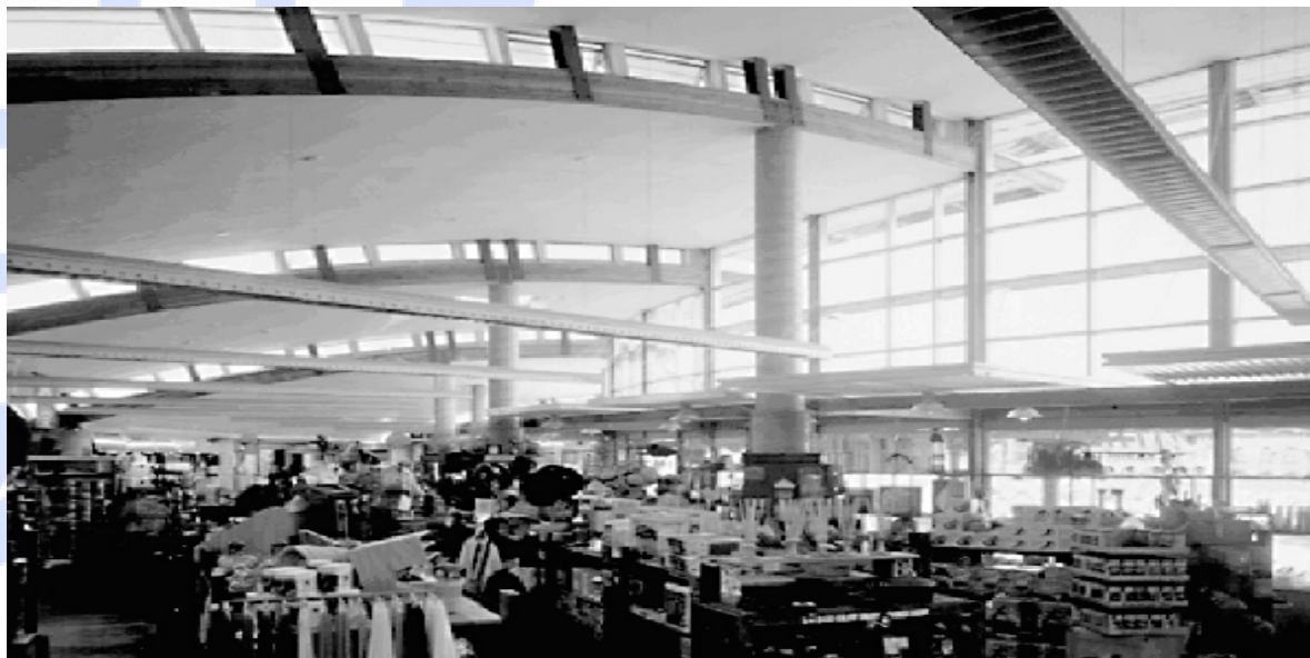
Fig. 12a, b: El Centro de Estancia Solar "The Real Goods" , una tienda de ventas al menudeo en Hopland, California, Estados Unidos (diseñada por Van der Ryn Arquitectos). Con un diseño "bioclimático" completo, el edificio cuenta con calentamiento solar pasivo, ventilación, iluminación y enfriamiento natural, electricidad fotovoltaica y paisajes naturales. El ahorro de energía de este diseño, al compararlo con uno convencional en el clima de Hopland, es de un 90%. Las ventas en la tienda son 50% por arriba de lo proyectado debido a su buen nivel de confort y a la iluminación natural de su interior.
